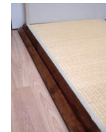
段差をなくす
